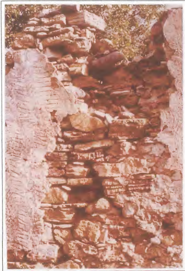
Foto 2.13. 1980 Muur opgebouwd uit blokken diabaas. Duidelijk zien we hier de gelaagd- heid van de dia- baassteen. Ook is een ge- deelte van de eer- ste pleisterlaag te zien. De stre- pen hierop die- nen voor een be- tere hechting van de tweede laag. (foto: M. Newton)
